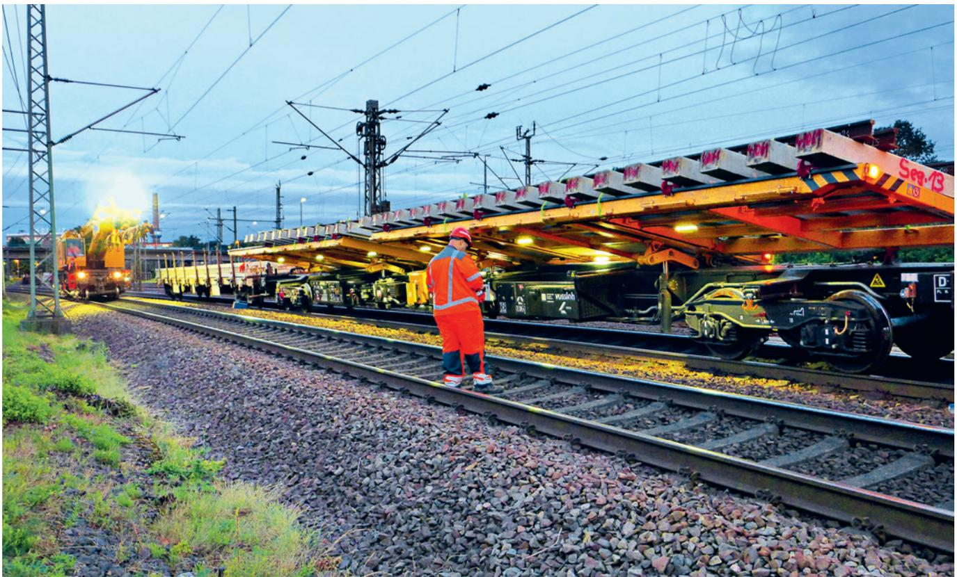
Im Baustellenbereich kann die Entladung an einem für den Weicheneinbau günstigen Ort erfolgen. Die niedrige Höhe der Ladeplattform des Switch Tilter ermöglicht das Entladen unter Oberleitungen.
