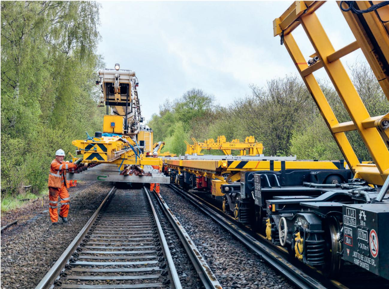
Die Kombination des Eisenbahnkrans oder Tracklayers mit dem Weichenwagen minimiert den Ressourcenverbrauch. Die Montage der Weichenmodule erfolgt in den Weichenwerken mit elektrisch angetriebenen Kranen. Der Transport erfolgt umweltfreundlich über die Schiene.
