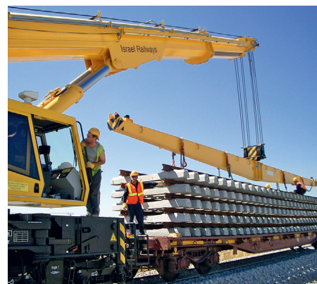
↑ Элементы пути укладываются напрямую с вагона на соседнем участке пути
