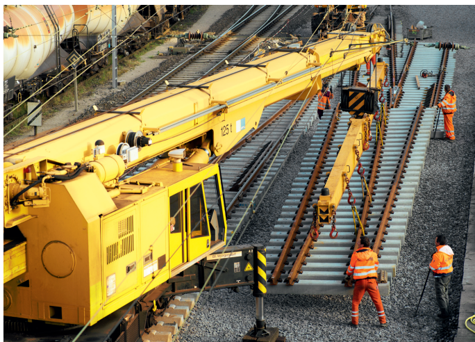
↑ Укладка элементов стрелочного перевода сбоку
