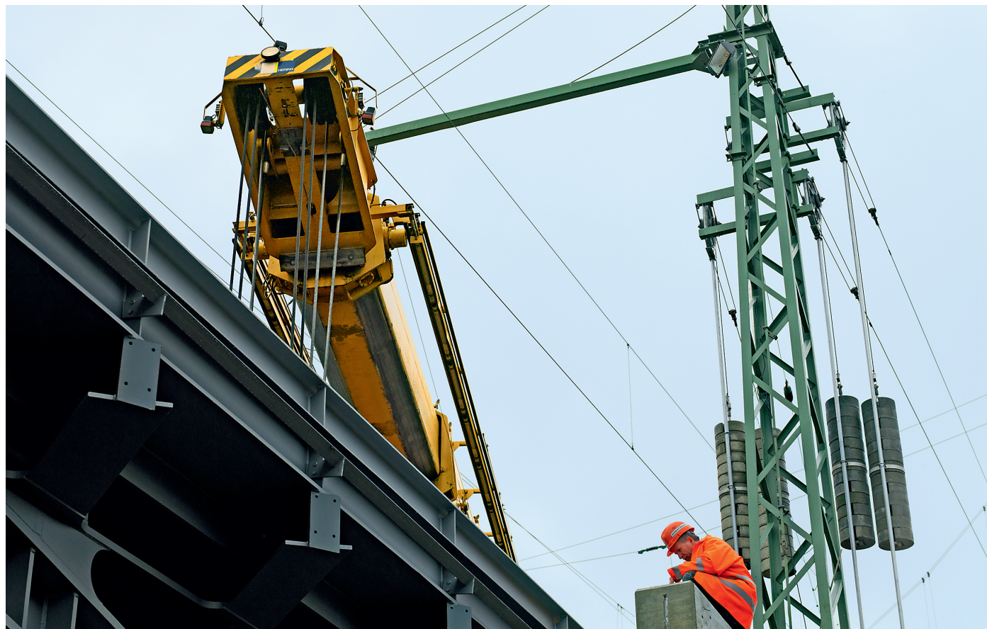
↑ Работа под линиями электропередач
