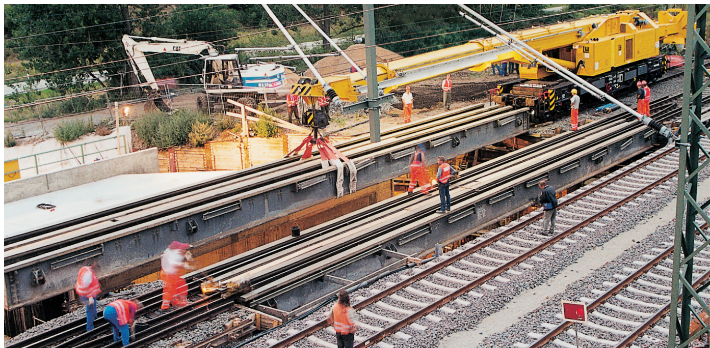
↑ Multi Tasker 1200 при подъёме крупнейшего вспомогательного моста DB AG
