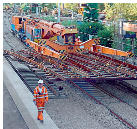
↑ Только Multi Tasker способен транспортировать столь широкие грузы
