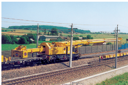
↑ Укладка элементов пути при ограниченном пространстве
