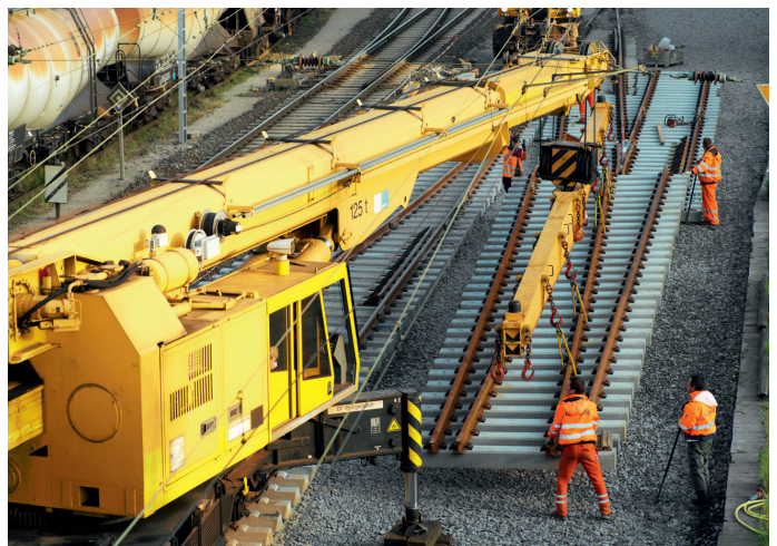
↑ Portions d'aiguillage posées latéralement
