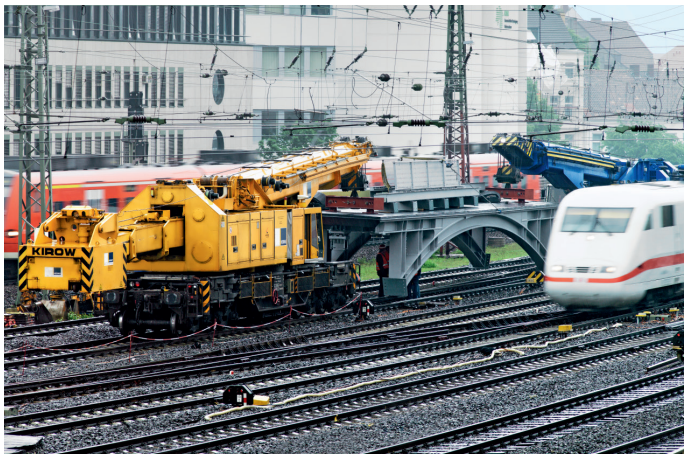
Construction de pont en mode tandem
