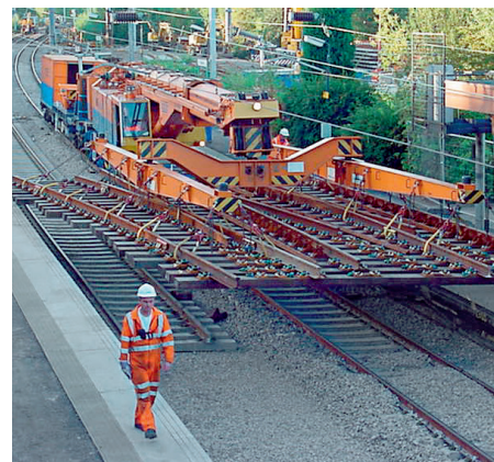
↑ Seul le Multi Tasker est capable de déplacer des charges d'une telle largeur sur les voies
