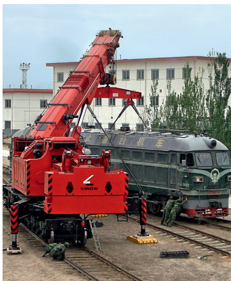
↑ Interventions après accident
