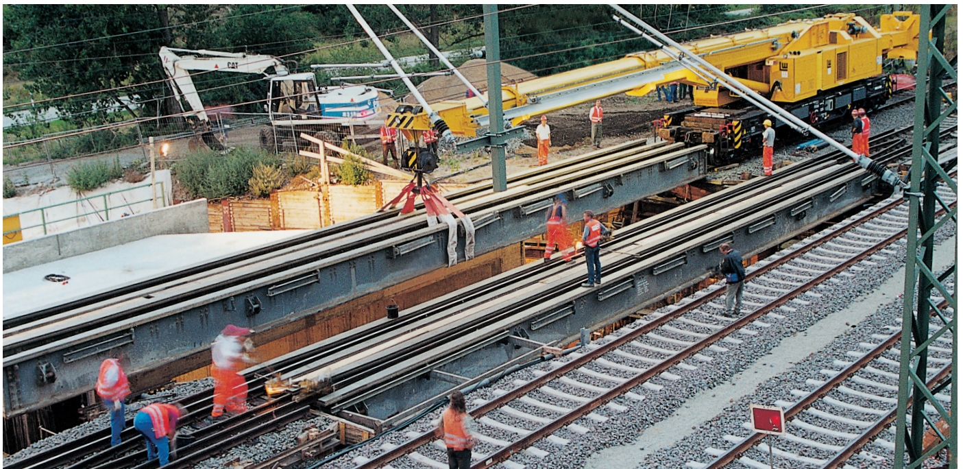
Multi Tasker 1200 lors du levage du plus grand pont provisoire de la DB AG
