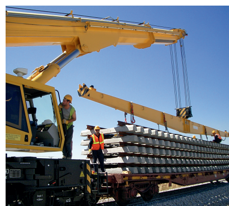
↑ Los tramos de vía se tienden directamente desde el vagón en el tramo contiguo
