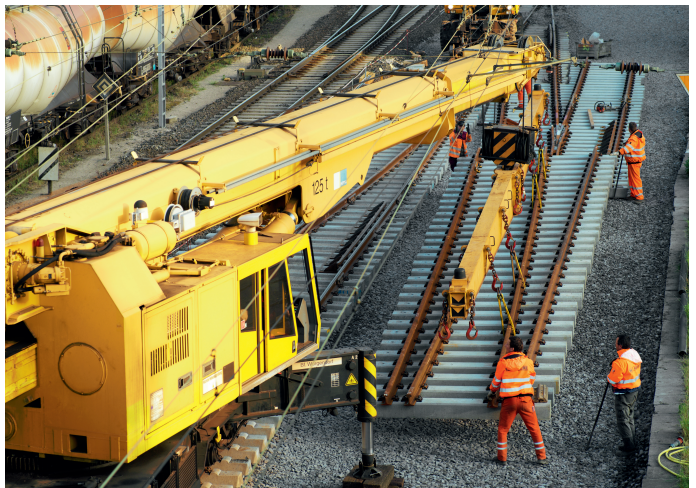
↑ Piezas de agujas depositadas lateralmente
