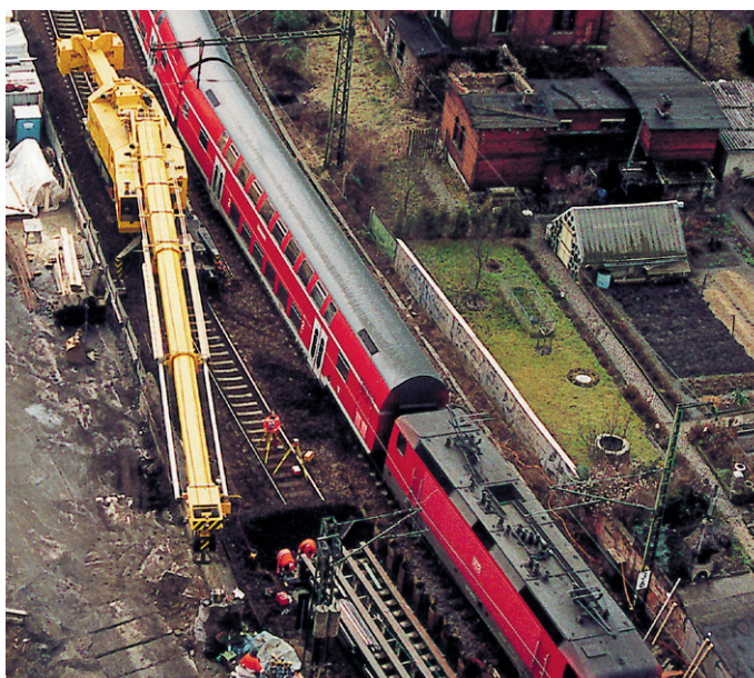
↑ La especial disposición de los contrapesos de la Multi Tasker permite trabajar sin perfiles con solo un apoyo
