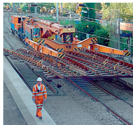
↑ Solo la Multi Tasker es capaz de desplazar cargas tan anchas por las vías
