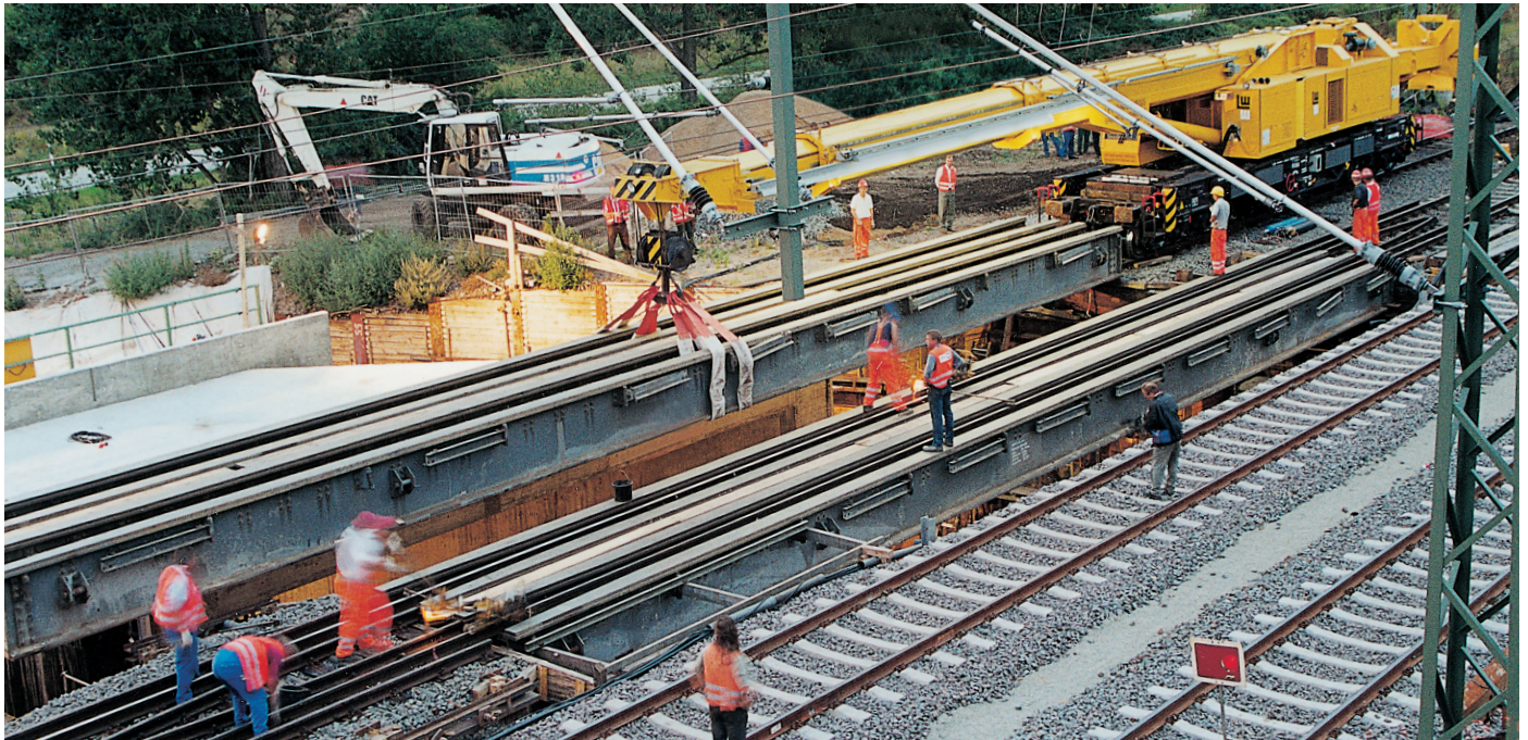
Multi Tasker 1200 elevando el puente auxiliar más grande de la empresa ferroviaria DB AG
