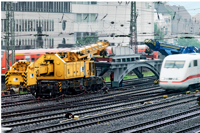
Construcción de puente con el procedimiento tándem
