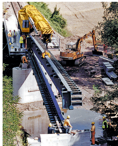
Eficiente montaje de vigas de puente
