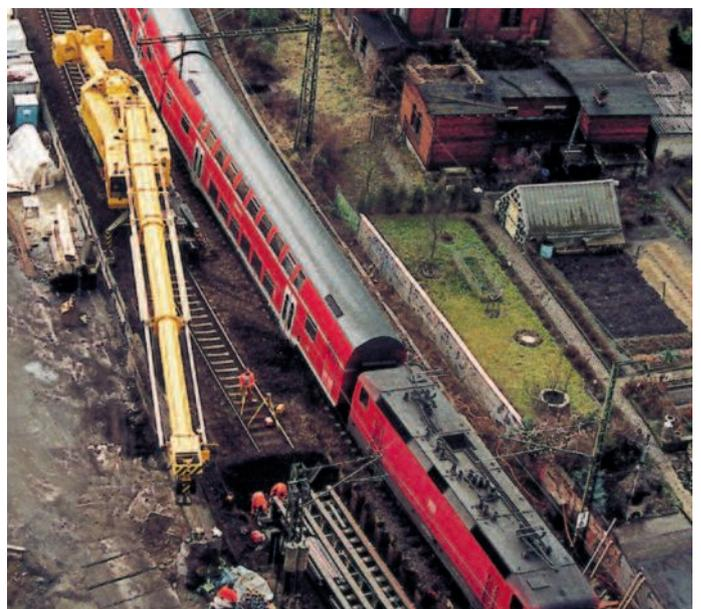
↑ Die spezielle Gegengewichts-anordnung des Multi Taskers ermöglicht das profilfreie Arbeiten mit nur einer Stütze
