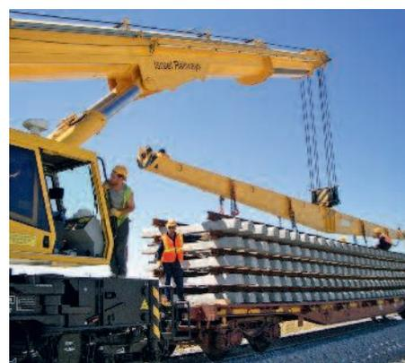
↑ Die Gleisjoch werden direkt vom Waggon auf den benachbarten Streckenabschnitt verlegt
