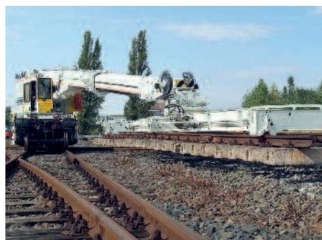
↑ Gleisjoch können mit hydraulischen Traversen bewegt werden
