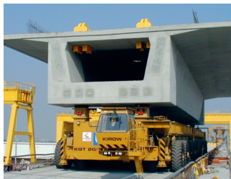
↑ Транспортировка готового элемента моста весом в 900 тонн
