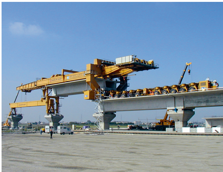
↑ Установка готового элемента моста
