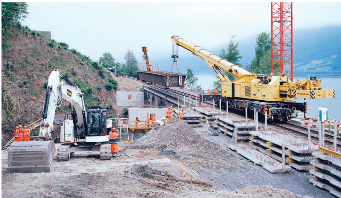
↑ Der KRC 1200 und KRC 1100 positionieren die Brücke über den Brückenlagern.
